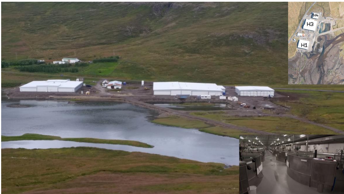
Mynd 4-1 Seiðaðisstöð fyrirtækisins Arctic Smolt ehf. í byggingu í Tálknafirði. Seiðastöðin samanstendur af þremur húsum H1, lengst til vinstri á myndinni, H3 í miðjunni og H4 er vatnshús lengst til hægri. Hús á milli H1 og H3 er ekki í notkun. Innfeld mynd efri: Loftmynd af svæðinu. Innfeld mynd neðri: frumfóðrunarker í húsi H3 (miðjuhúsið).
